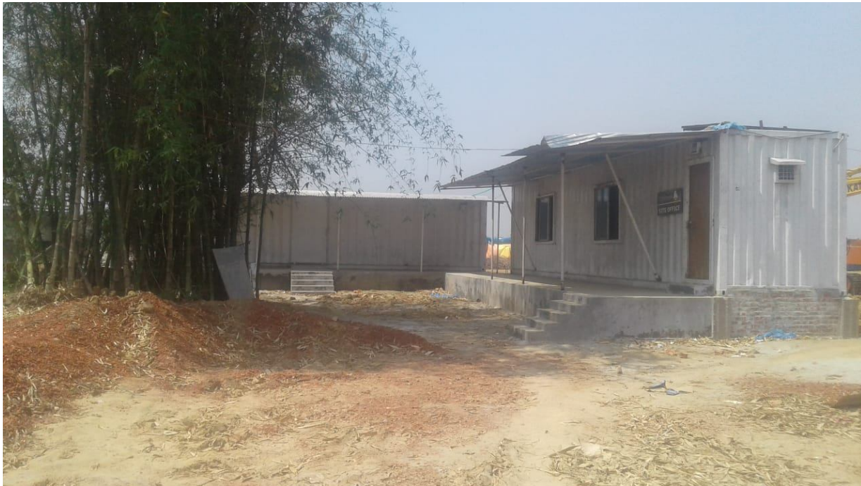
28 Mar 2020 : Site Office
