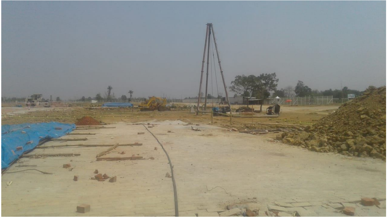
28 Mar 2020 : Piling Rig
